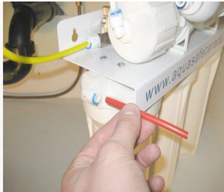
Fig.9: Insérez une extrémité du tube de 4 pouces rouge dans le "IN" du coude
