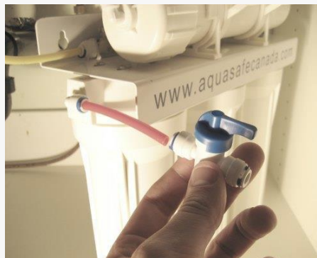
Fig. 10: Insérez dans l'autre extrémité du tube le robinet d'arrêt.
